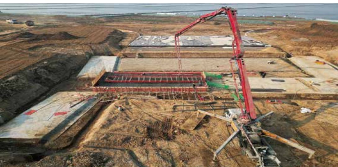
安徽省淮河流域重要行蓄洪区建设工程霍邱段建设现场
