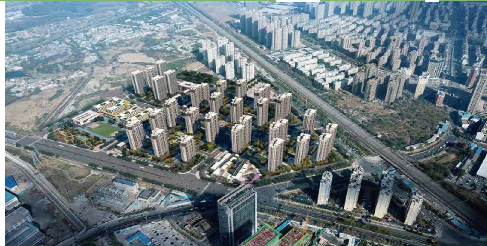
安徽一建新西站片区10、12地块安置点工程鸟瞰图
